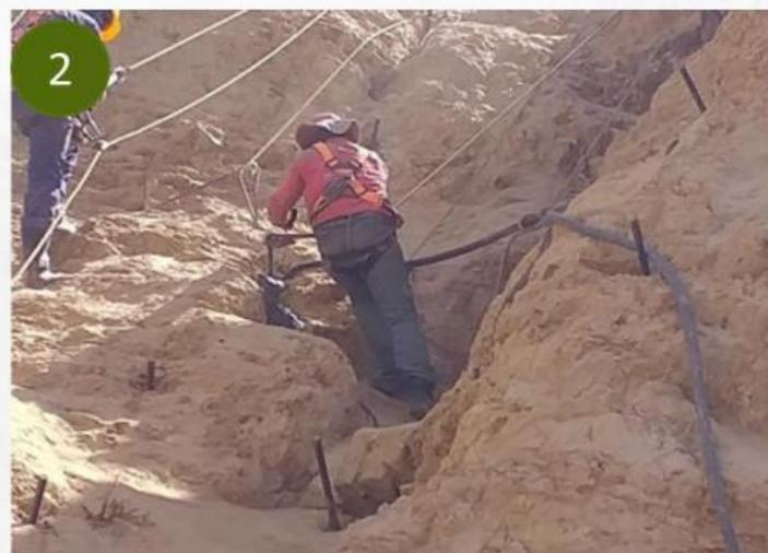
Se anclan **pernos** en la superficie del talud, para luego colocar el geotextil de protección.
