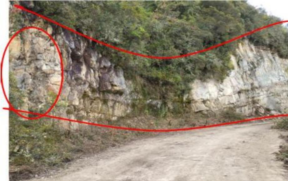
**El terreno está muy fracturado;** presenta fracturas en diferentes direcciones, que se encuentran separadas entre sí entre 10 y 50 cm.
