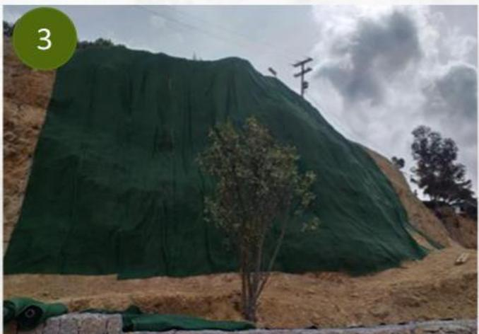
Se coloca **geotextil** de protección en toda la superficie expuesta del talud
